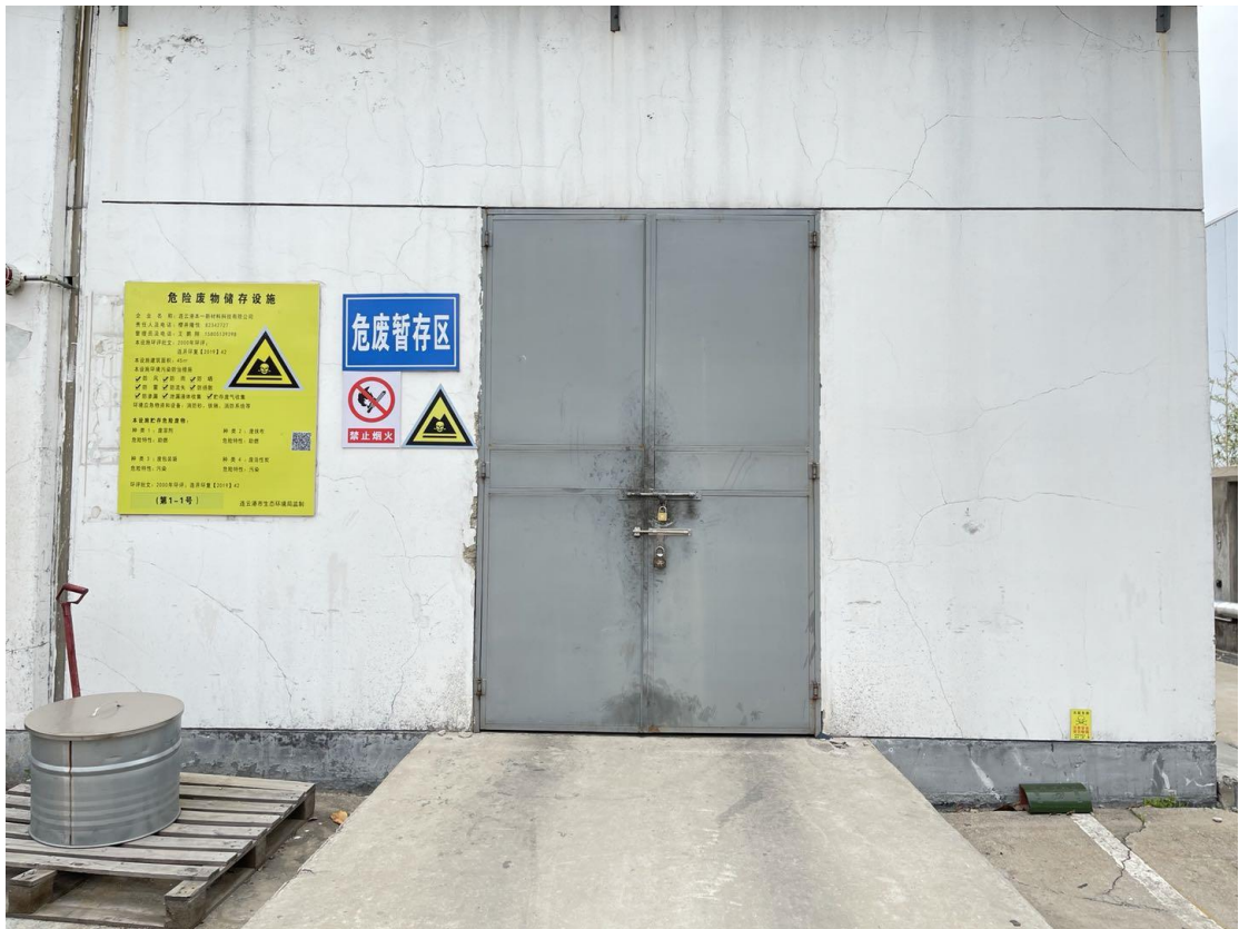
本一危废暂存库
