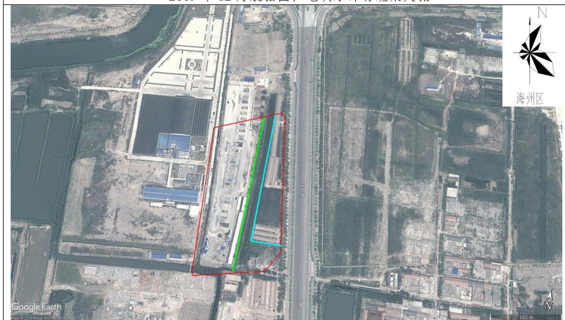
2012 年 5 月航拍图，地块西部建成驾校，民房拆除，地块东部蔬菜大棚规模有变化
