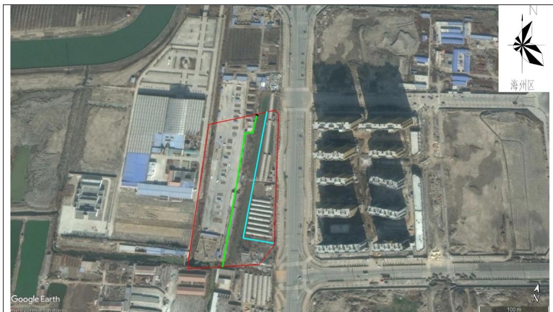
2015 年 1 月卫星图，地块内驾校开始新建板房，作为办公室使用
