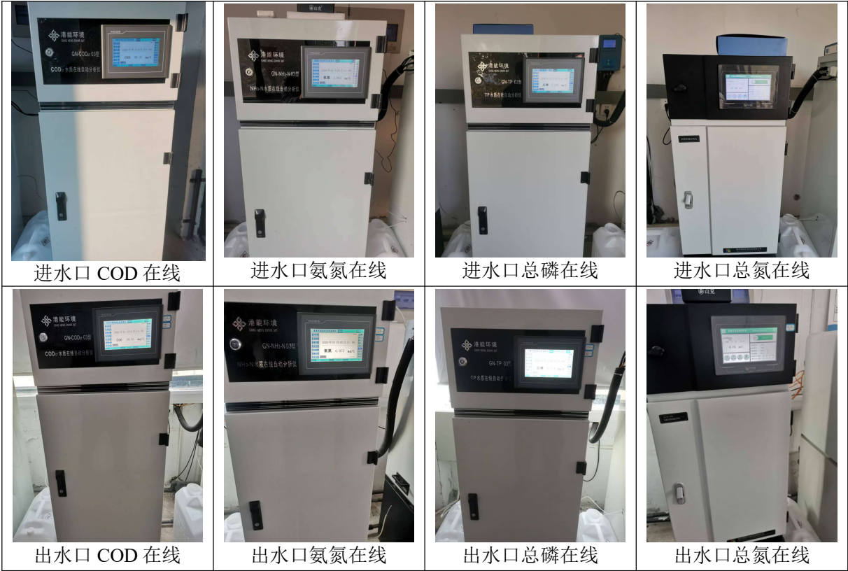
图 4.1-6 自动监控设施设置照片
