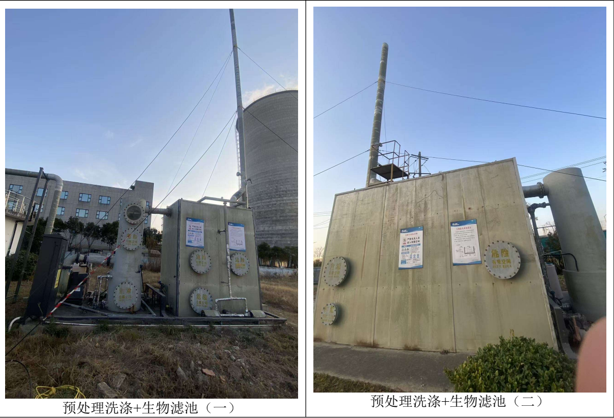
图 4.1-3 废气治理设置照片
