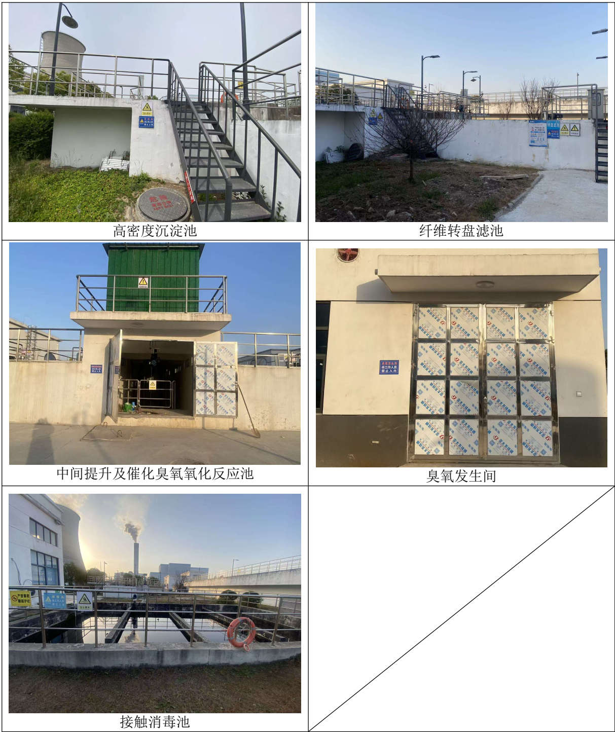
图 4.1-1 污水处理设施照片
